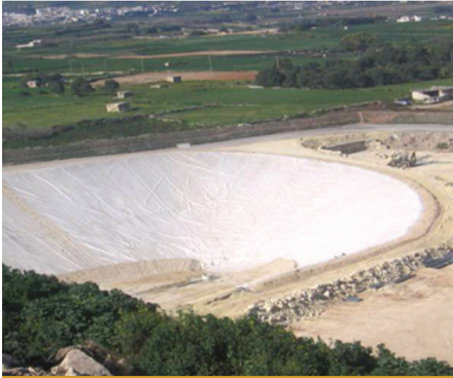
Fil-miżbliet moderni, l-iskart jintrema f'hofoor kbar miksija bi plastik oħxon. Il-meraġ tossiku li jnixxi qalb l-iskart jiġi ppumpjat u msaffi biex b'hekk ma ssir l-ebda ħsara lill-ħażna tal-ilma tal-pjan. Il-gassijiet jingabru wkoll u jintużaw għall-produzzjoni tal-elettriku.
